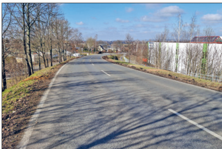
Nachdem bei der Erneuerung der Stollberger Straße in der 9. Kalenderwoche die Pappeln gefällt und die Leitplanken entfernt wurden erfolgte in der Woche danach das Abfräsen des alten Straßenbelages.
