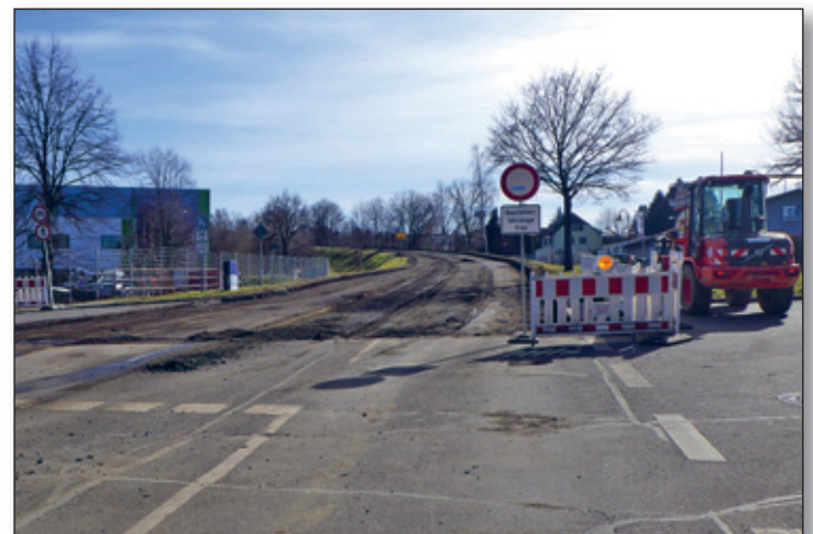
Nachdem bei der Erneuerung der Stollberger Straße in der 9. Kalenderwoche die Pappeln gefällt und die Leitplanken entfernt wurden erfolgte in der Woche danach das Abfräsen des alten Straßenbelages.
