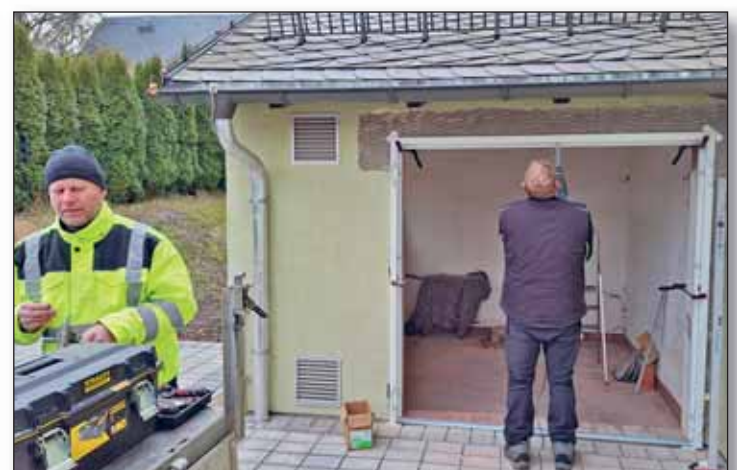
Die Mitarbeiter des Bauhofes kontrollierten die Dachrinnen an der Schule und am Rathaus. In der Feuerwehr musste als Vorbereitung für den Einbau einer Notstromversorgung eine breitere Tür eingebaut werden.
