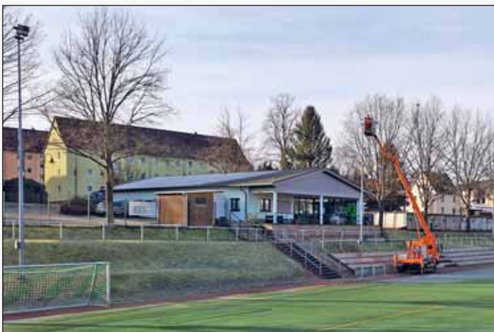
Der Kommunale Zweckverband Stadtbeleuchtung reparierte und reinigte die Flutlichtanlage des Sportplatzes.
